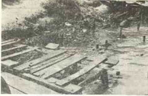
Haliç'te terk edilmiş iskele ile molozlar.
